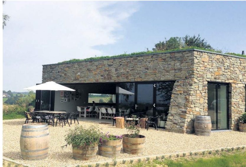
Het gloednieuwe wijnbouwkenniscentrum in Vijlen.
